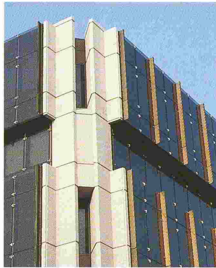
Aux angles du bâtiment, le passage des façades à la structure en béton est adapté au rythme choisi pour les lignes horizontales.
