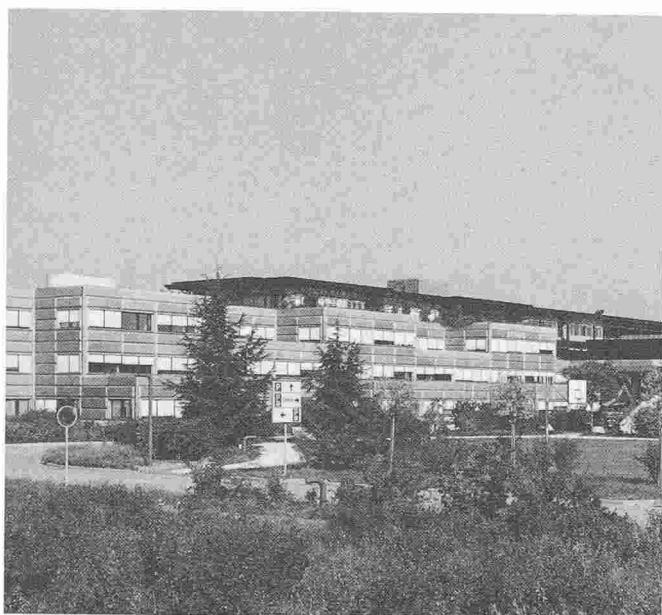
Ecole polytechnique fédérale de Lausanne, Ecublens, étape 2; maître d'ouvrage: Conseil des EPF, Lausanne; architecte: B. Vouga + Réalisations scolaires et sportives SA, Lausanne.
