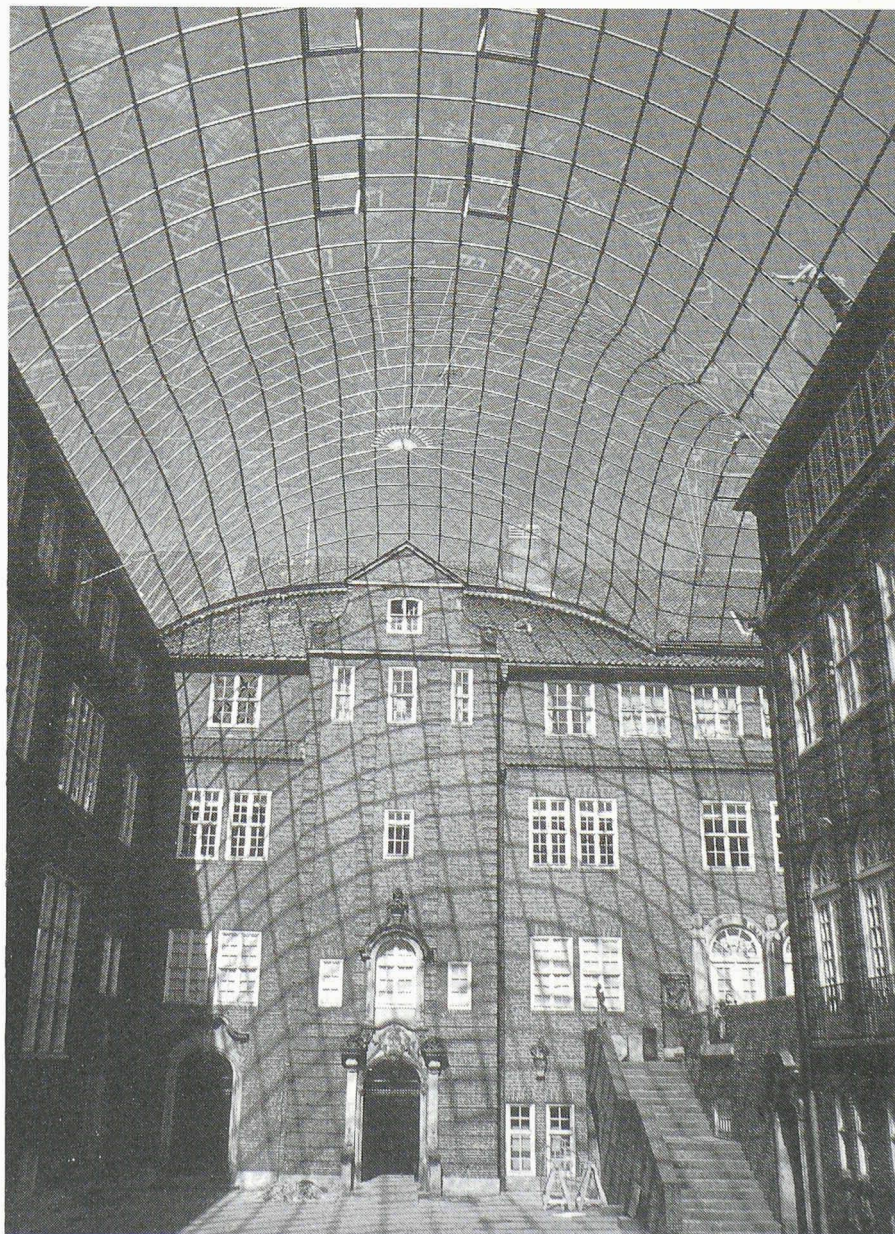
Fig. 5, 6 et 7. - Couverture de la cour intérieure du Musée d'histoire hambourgeoise à Hambourg par J. Schlaich, R. Bergermann, K. Friedrich et H. Schober, Stuttgart. Vue depuis la cour et détails.
