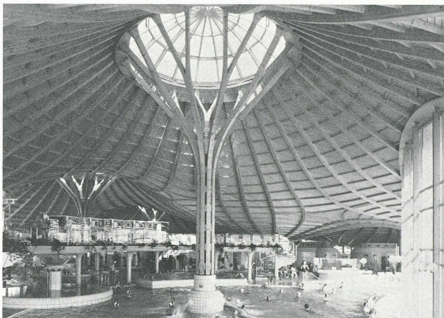
Fig. 4. - Coque nervurée en bois recouvrant les bains d'eau salée à Bad Dürkheim par F. Wenzel et associés, Karlsruhe, et H. Linkwitz et associés, Stuttgart.
