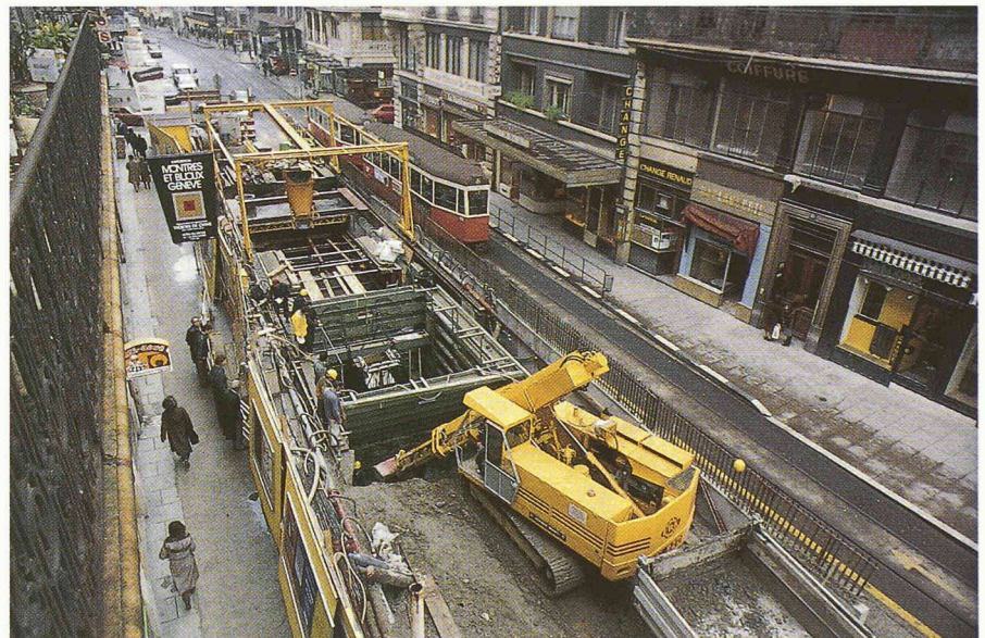
Fig. 6. - Organisation «compacte» du chantier: travaux d'excavation suivis du bouclier, du dispositif de bétonnage et de la fermeture de la fouille. Le trafic est maintenu sur les deux trottoirs et sur une partie de la chaussée avec une voie provisoire du tram.
