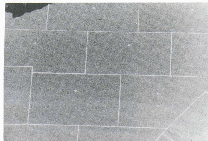
Fig. 8, 9. - Tandis que la façade retravaillée « jusqu'à la pierre saine » avec de nouveaux joints semble figée et reconstruite mécaniquement « comme neuve », on peut encore déchiffrer sur la partie jointoyée, uniquement nettoyée selon les besoins, les traces du façonnage et du vieillissement.
