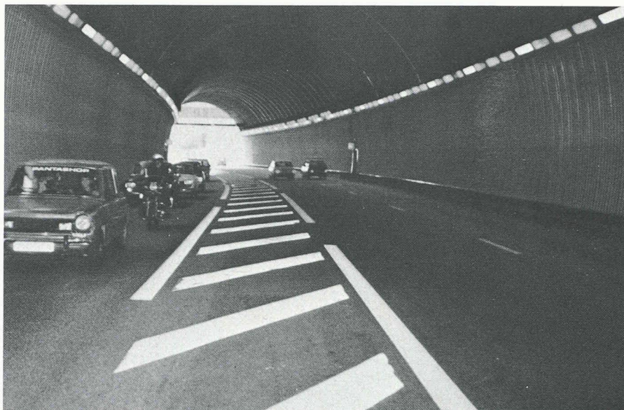
Fig. 9. – Séparation des voies dans un tunnel bidirectionnel.
