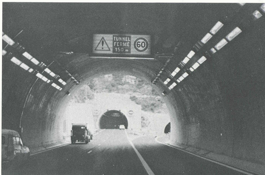
Fig. 10. – Le tunnel à 150 m est-il vraiment fermé ?
