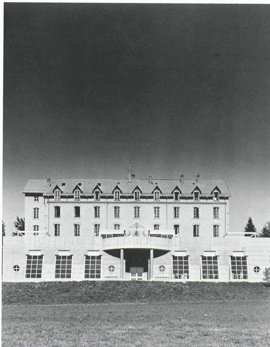
L'ancien bâtiment et le soubassement de 1984-1985.
