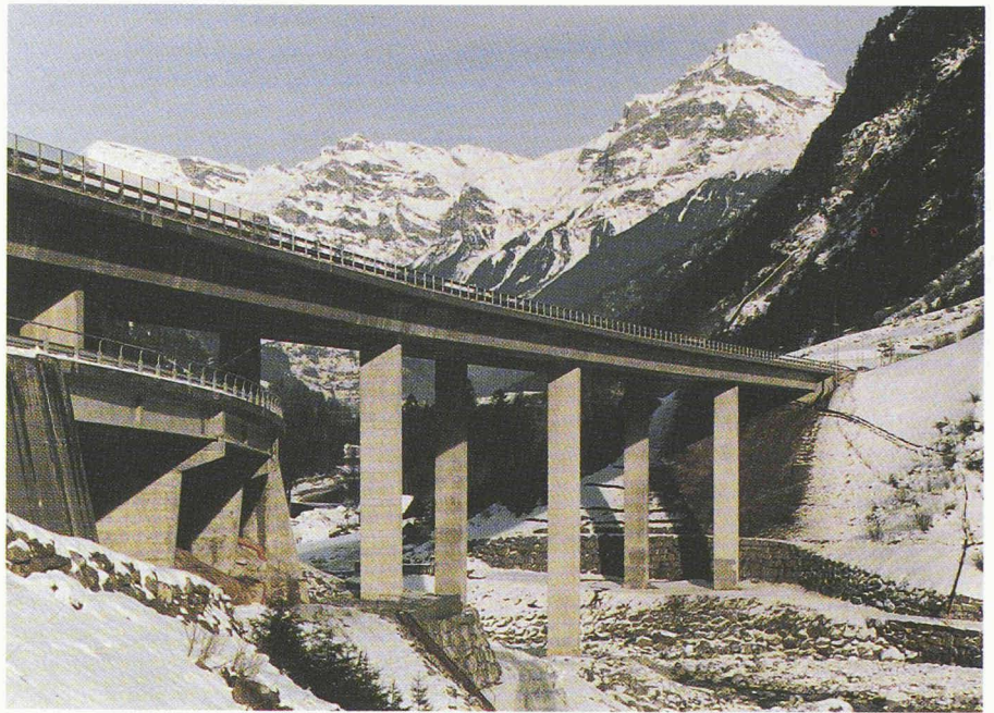
Fig. 8. - Le pont reconstruit.
