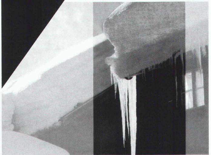
La mauvaise évacuation de l'eau due au dégel de la neige des toits, provoqué par le rayonnement solaire et la chaleur du bâtiment, occasionné de gros dégâts aux installations: descentes éclatées, chéneaux affaissés, siphonnage de la toiture, etc...
