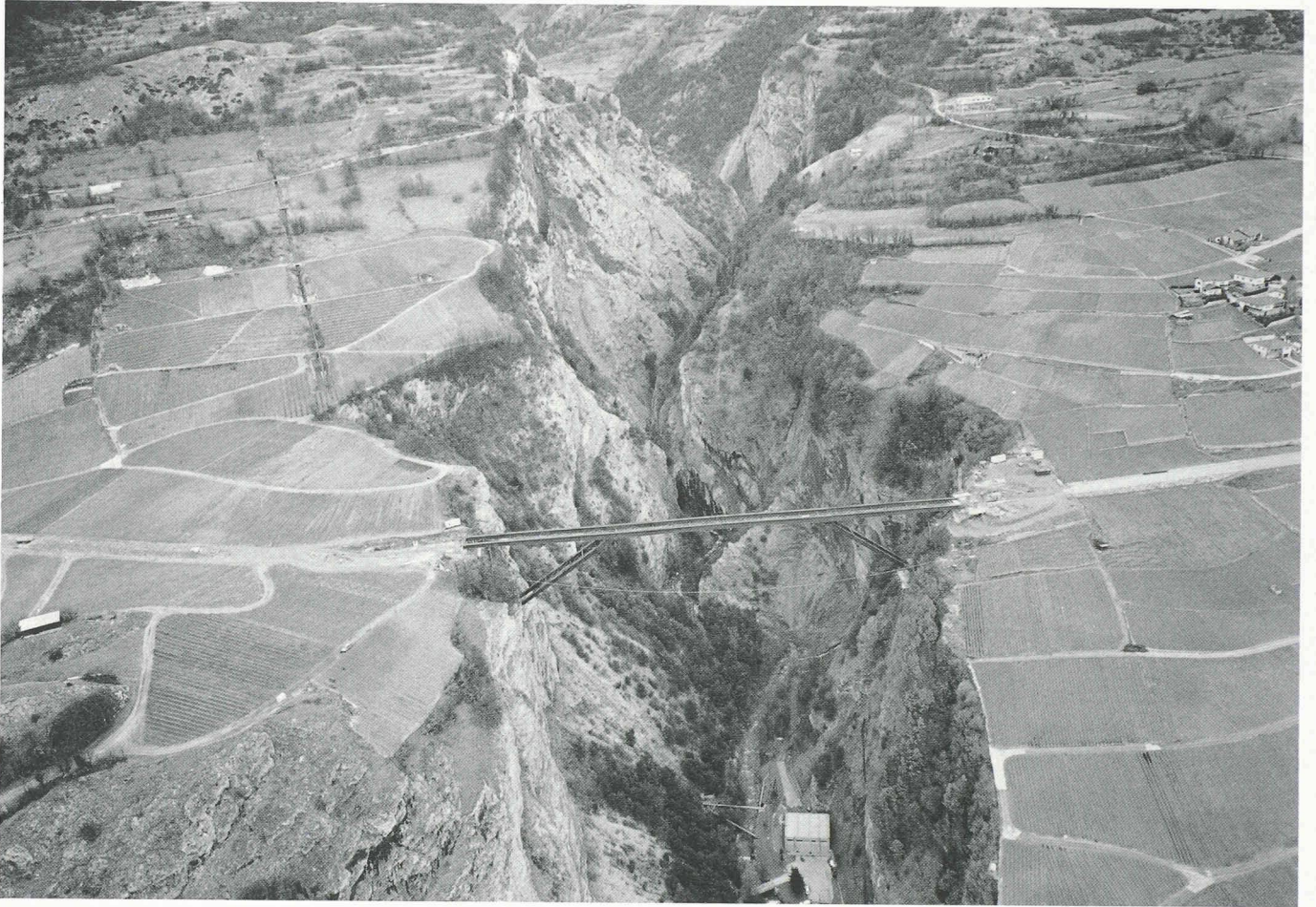
Pont routier sur la Dala, entre Loèche et Varone.
