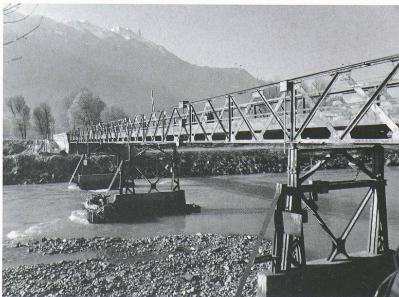
Fig. 1. — Vue de l'ancien pont métallique
