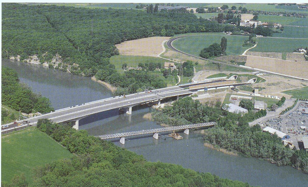
Pont d'Aigues-Vertes: vue aérienne
