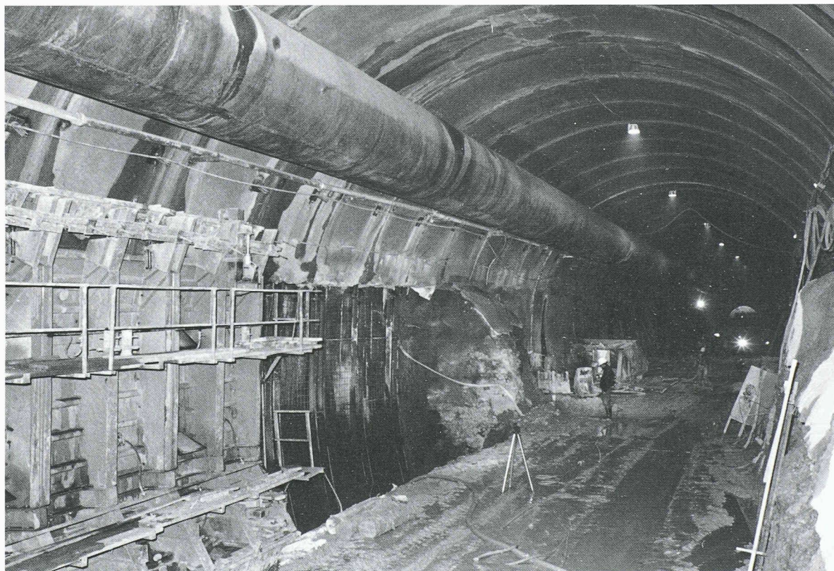
Fig. 10. — Réalisation d'un piédroit
