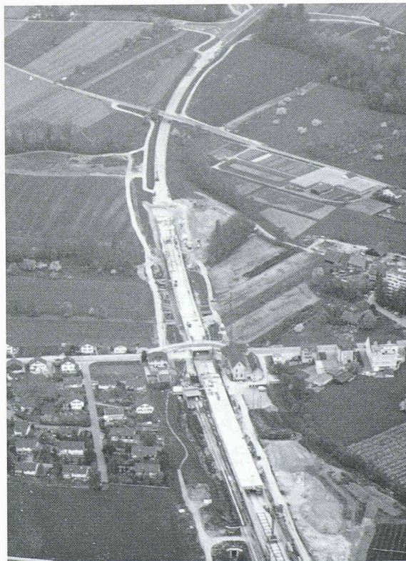
Vue d'ensemble du tronçon en cuve avec ses parties couverte et ouverte (à l'arrière-plan)
