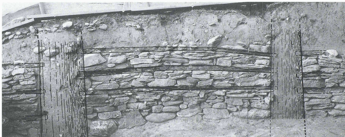
Fig. 5. – Vue du mur de refend nord de la tour sud (les fils sont distants de 1 m). Restitution graphique des éléments en bois
