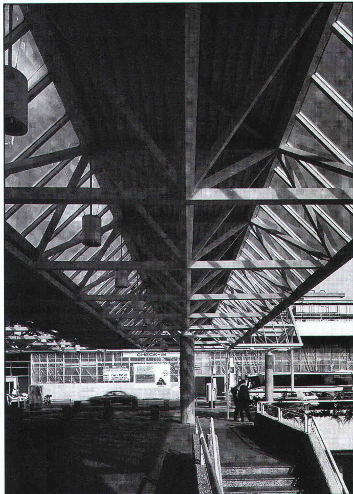
Poutres triangulaires en RHS au-dessus de la station d'autobus à l'aéroport de Genève-Cointrin. (Ing.: Realini, Bader et Associés, Genève)
