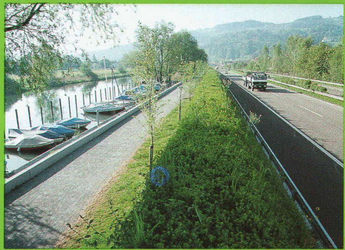
CH-Rheineck, NI 1990-91; H = 2,5-4,0 m, L = 2800 m; Ouvrages anti-bruit à une et deux faces
