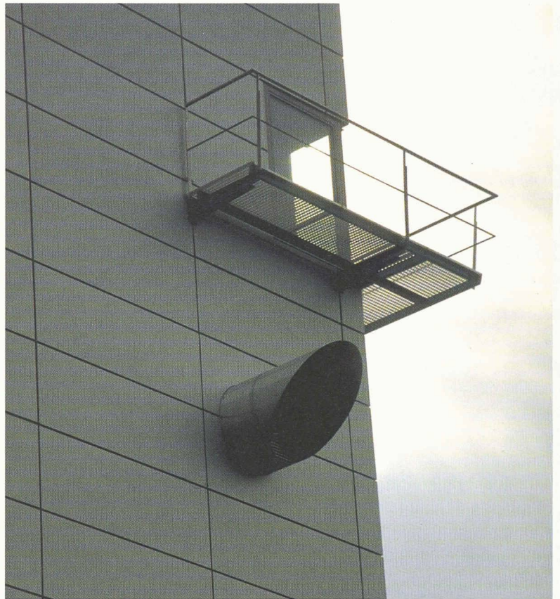
Détail façade ouest
