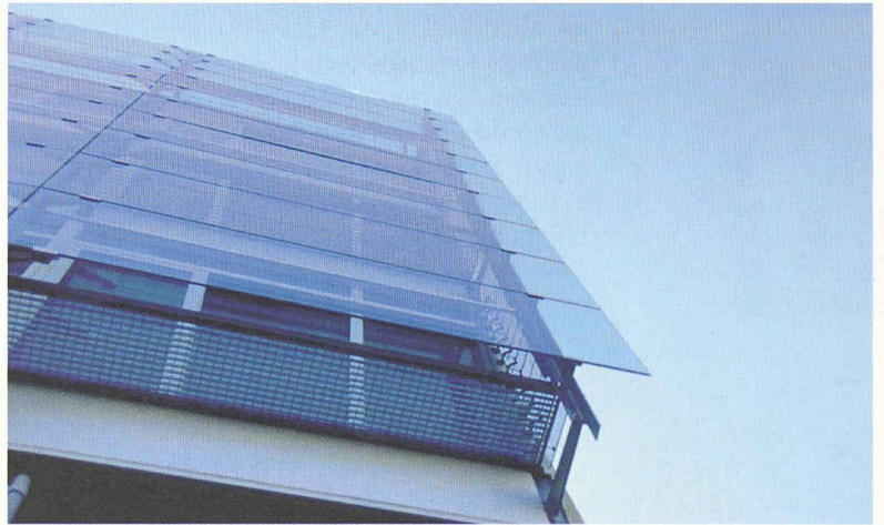
Détail façade est
