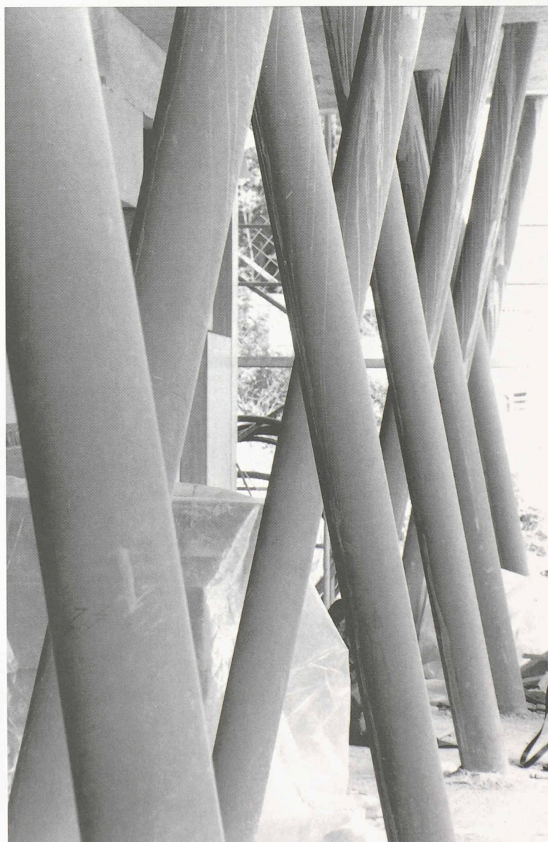
Structure porteuse, rez-de-chaussée
