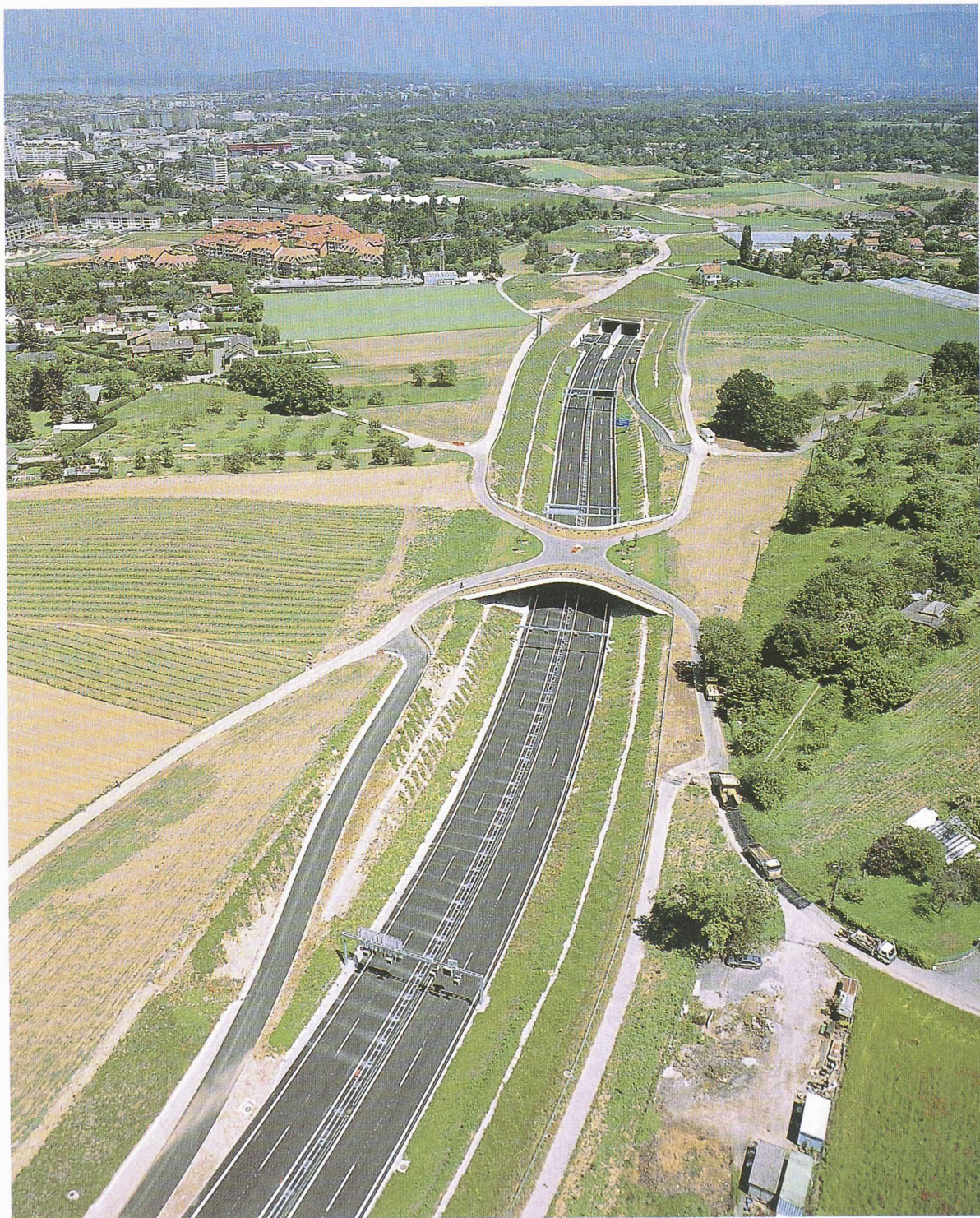
Le pont des Vaulx rétablit la continuité des circulations locales dans la campagne traversée par l'autoroute en tranchée
