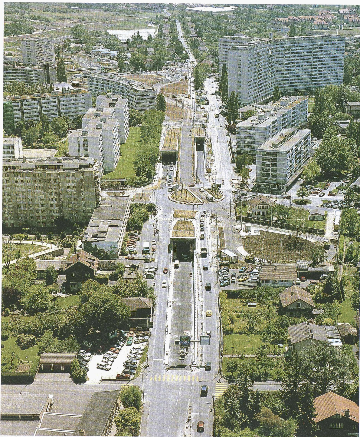
Implantée dans un quartier de forte densité, la tranchée couverte des Palettes permet de restituer la surface au trafic local alors que ses différentes bretelles d'accès lui permettent de s'intégrer dans le réseau dense des circulations.
