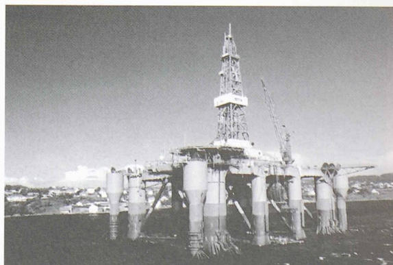
Plate-forme pétrolière en construction
