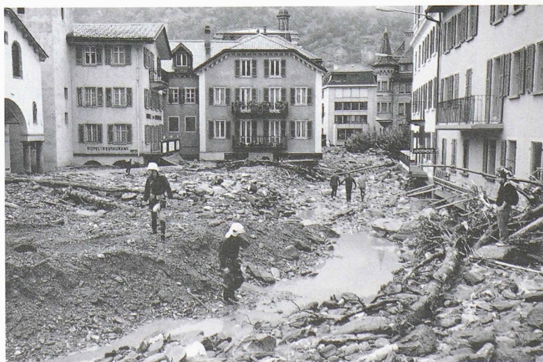
Fig. 2. – La crue de la Saltine à Brigue-Glis le 24 septembre 1993 (Photo G. Escher)
