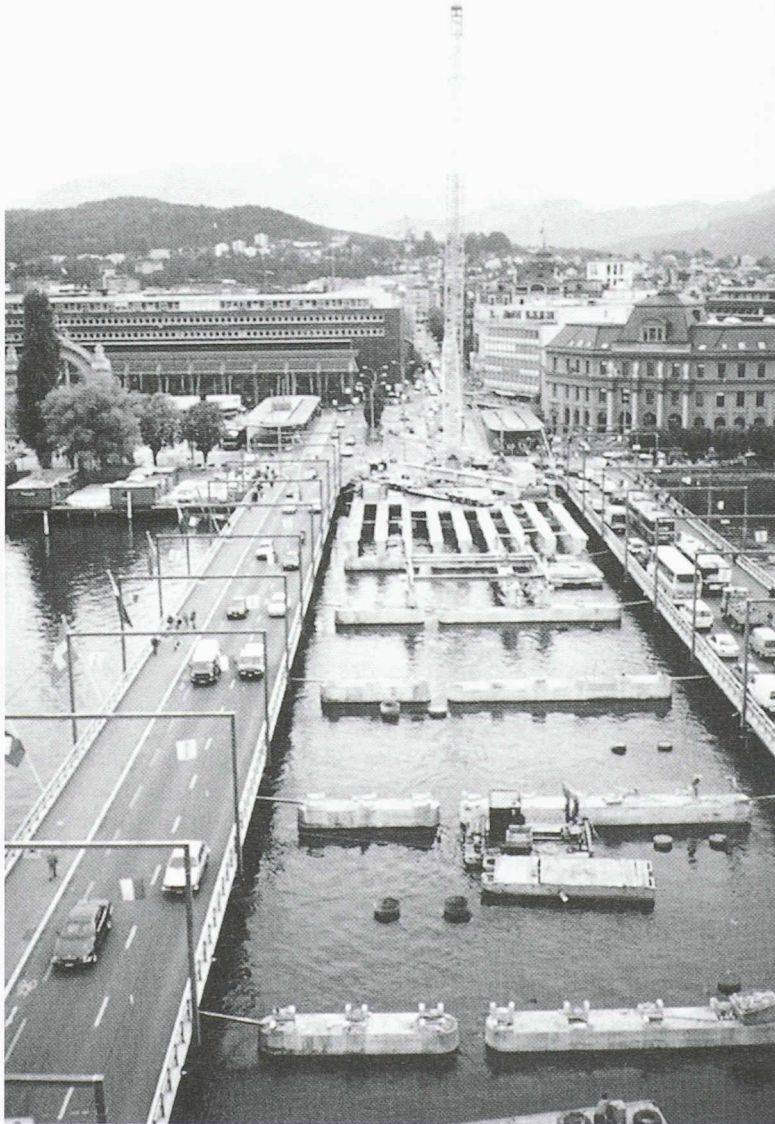
Fig. 6. - Pendant la démolition de l'ancien et la construction du nouveau pont, le trafic est assuré par deux ouvrages provisoires.
