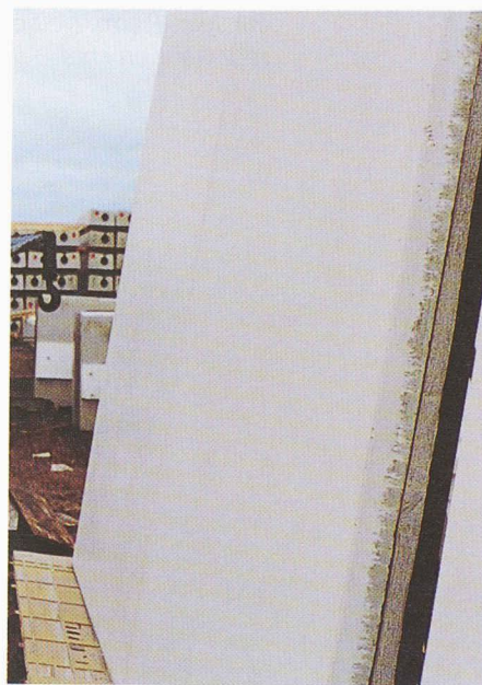
Fig. 2. – Élément préfabriqué pouvant être utilisé comme structure porteuse ou comme coffrage perdu dans la partie arrondie de la section du tunnel
