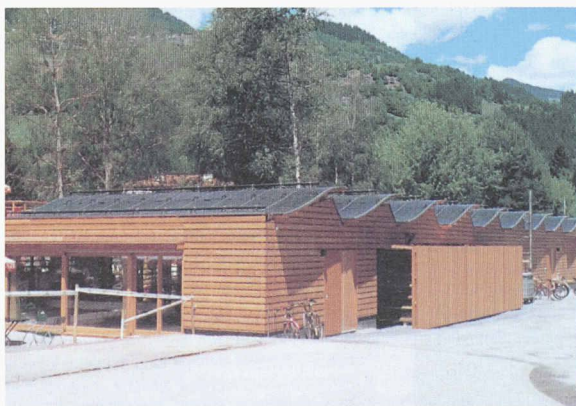
La TOITURE SOLAIRE AS sur une piscine dans les Grisons (photo Energie solaire SA)
