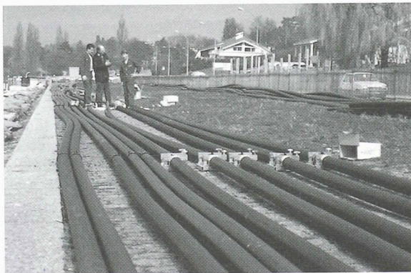
Pose de tubes sur un chantier (Genève)
