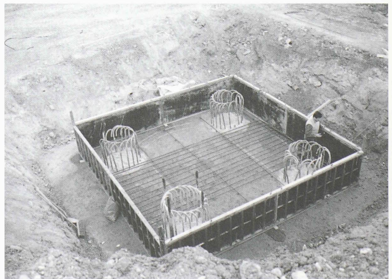
Fig. 3. – Fondation sur pieux rive gauche
