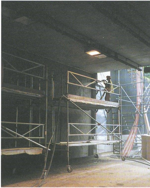
Fig. 6.- Enrobage du treillis par béton projeté
