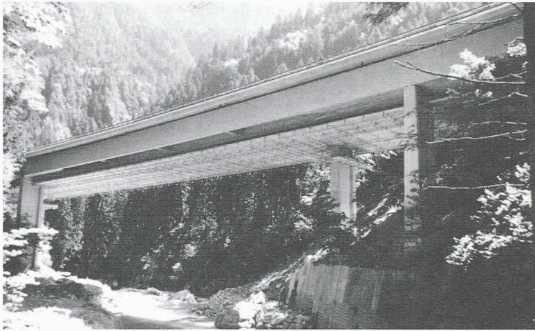
Fig. 1. – Partie sud du pont enjambant la Reuss
