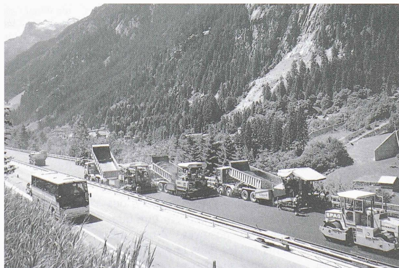
Fig. 4. - Application sans raccords de mastic de gravillons avec l'engagement de trois engins sur la voie «Romeo»
