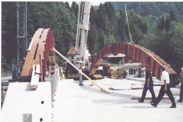
Fig. 6. – Montage des arcs à l'aide d'un camion-grue
