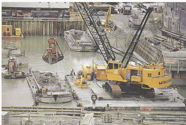
Fig. 1. - Des méthodes de construction ménageant la nappe phréatique peuvent créer des lacs dans les fouilles. L'excavation doit alors recourir à des « dragues flottantes » pour travailler sous l'eau. (Photo F. Pierlings)
