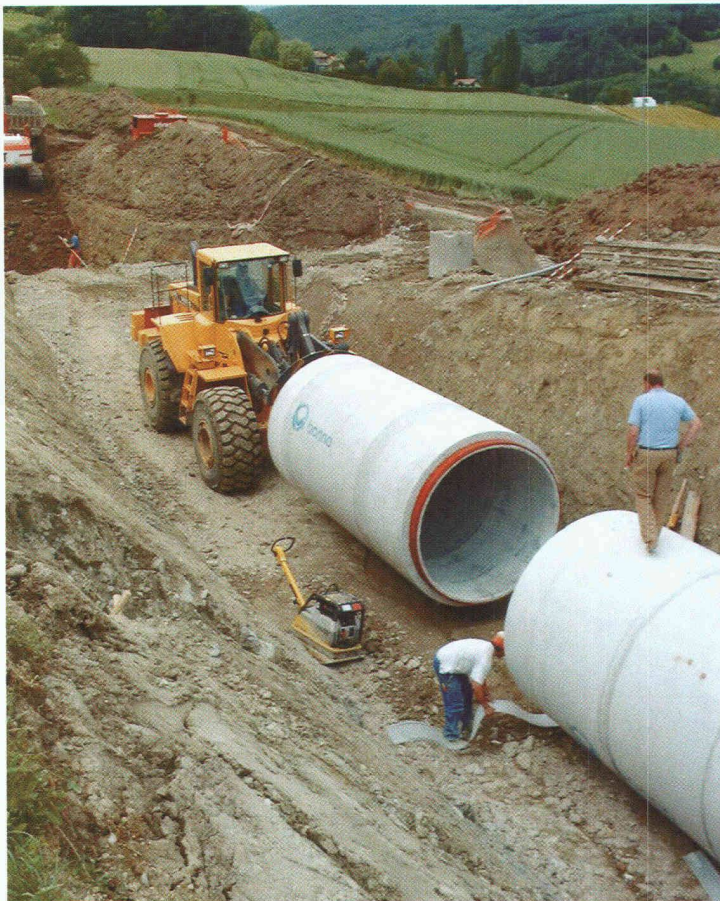
Mise en place d'un tuyau DN 2000 mm de la conduite d'amenée (L=2900 m)
