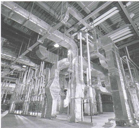
Fig. 3: Vue de l'ensemble des amenées d'air et de fluides au niveau du plafond d'une salle blanche. Le domaine biomédical exige des taux de renouvellement d'air particulièrement élevés et les équipements occupent souvent plus d'espace que la salle elle-même.
