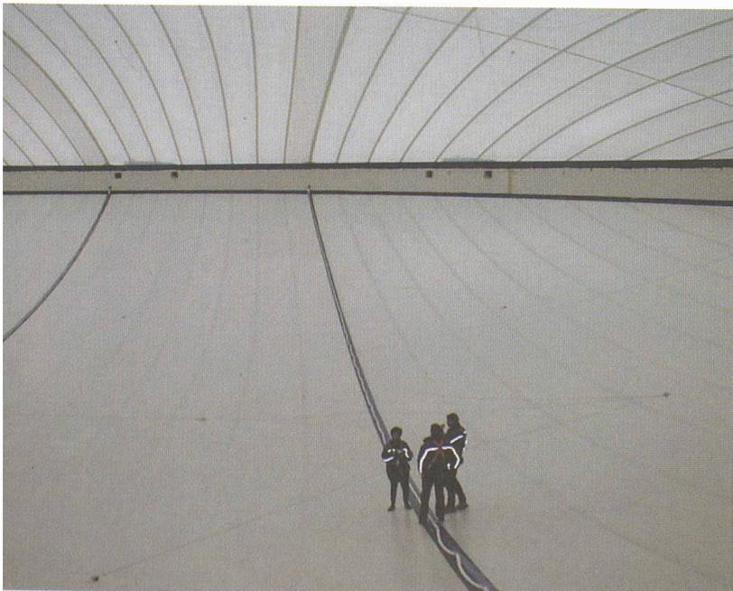
Après l'assemblage complet de l'anneau, on a procédé à la pose des membranes: les deux membranes sont d'abord déployées sur la plate-forme, puis étirées au moyen de tire-fort pour être fixées sur les bords de l'anneau. Le montage des membranes du galet N°1 a nécessité 150 tire-fort répartis sur la circonférence.
