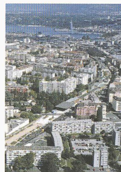
Vue d'ensemble de la couverture des voies CFF à Genève (Photo: Alain Grandchamp)
