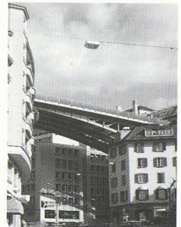
Le pont Bessières vu depuis la rue St-Martin (Photo Ville de Lausanne, Service des routes et voirie)
