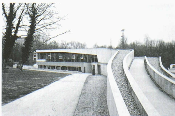
Centre international de l'Environnement, Weil-am-Rhein (Photo Eugène)
