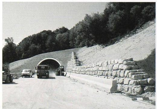
Fig. 10 : Tunnel de la Lance côté lac, calotte-stross excavé en classe IVb
