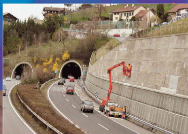
Murs de soutènement
