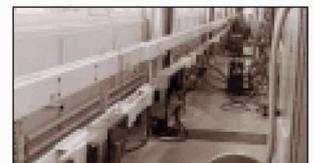
**Canalisations électriques LANZ HE IP 68 à gaine de résine synthétique 400 – 6000 A pour transport et distribution du courant.**
