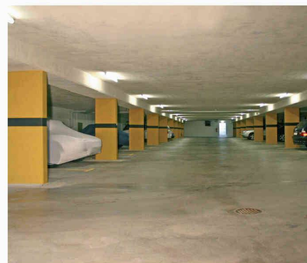
Garage souterrain après assainissement avec le système Sika
