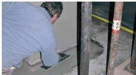
Réagrégage au pied des piliers Sikagard Sikagard®-720 EpoCem®
