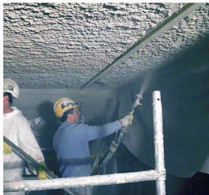
Application de Sika-Cafco® 300 par projection humide.
