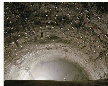
Têtes d'ancrages, Sud du tunnel de base du St-Gothard (Photo Milo Keller/ECAL)
