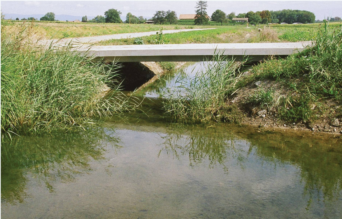
Fig. 17 : Vanne mobile à la hauteur du pont de La Motte (Photo O. Zimmermann)
