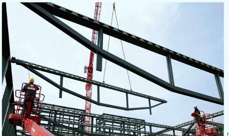
Fig. 1 : Vue d'ensemble d'un élément du plancher-dalle à sous-tirant lors du montage (Photo Luc Buscarlet)
