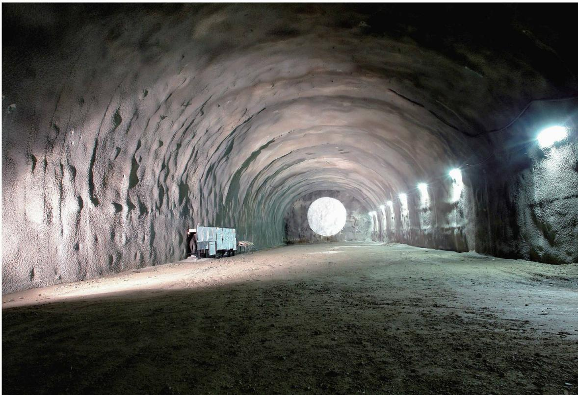
Fig. 8 : Section type de la CAOP ouest rendue opérationnelle pour le trafic ferroviaire. Une enveloppe en béton circonscrit le passage des trains afin de ne pas rompre la continuité aérodynamique du tracé.
