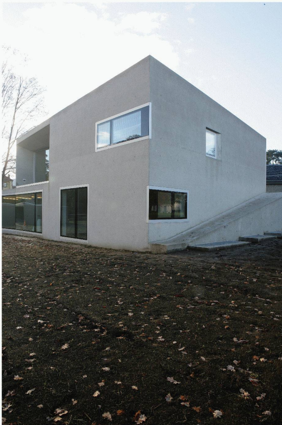
Fig. 20 : Vue de l'articulation entre la serre et le nouveau volume bâti (Photo Francesca Giovanelli)
