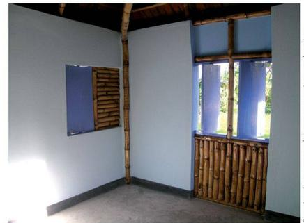
Construction vernaculaire avec ossature en bambou
