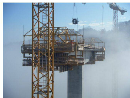
Construction des viaducs du Creugenat. (Photo GVH)
